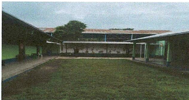
Foto 1: mejoramiento de estructura y cubierta de patio
