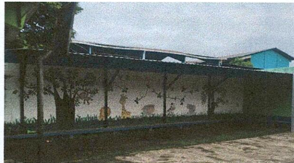
Foto 2: mejoramiento de losa de patio
